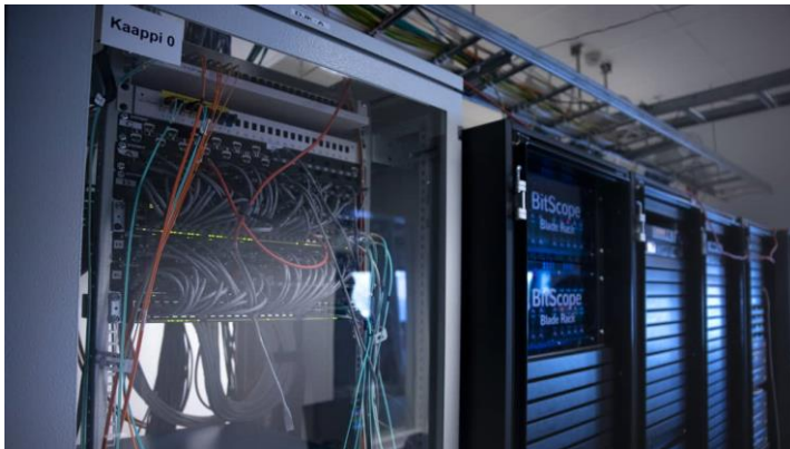
Kuva 2. IoT-laitteen keräämä data käsitellään datakeskuksessa, jolloin siitä saadaan hyöty irti. Kajaanin ammattikorkeakoululla on tällainen datakeskus opetuskäytössä. Kuva: Timo Sihvonen / Yle
