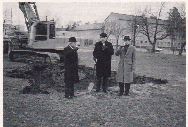
Maljankohotus käynnisti yliopiston uudisrakennuksen rakentamisen Palosaarella 21.12.1992. Vas. Vaasan korkeakoulujen rakentamisen neuvottelukunnan puheenjohtaja Mauri Palomäki, rehtori Ilkka Virtanen ja kaupunginjohtaja Juhani Turunen.
