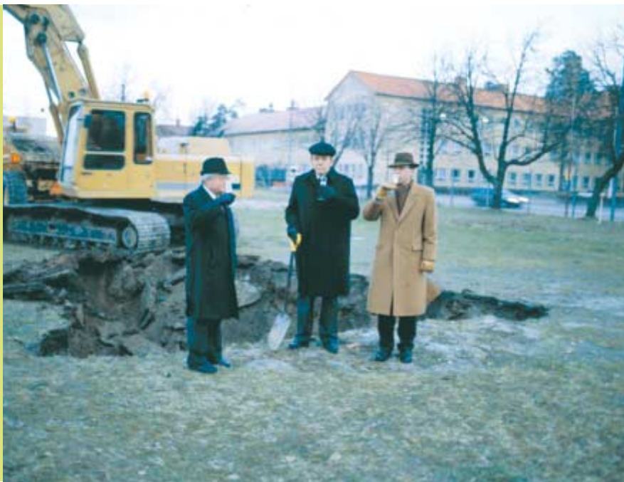
Uuden yliopistokampuksen rakennustyöt aloitettiin 21.12.1992.
