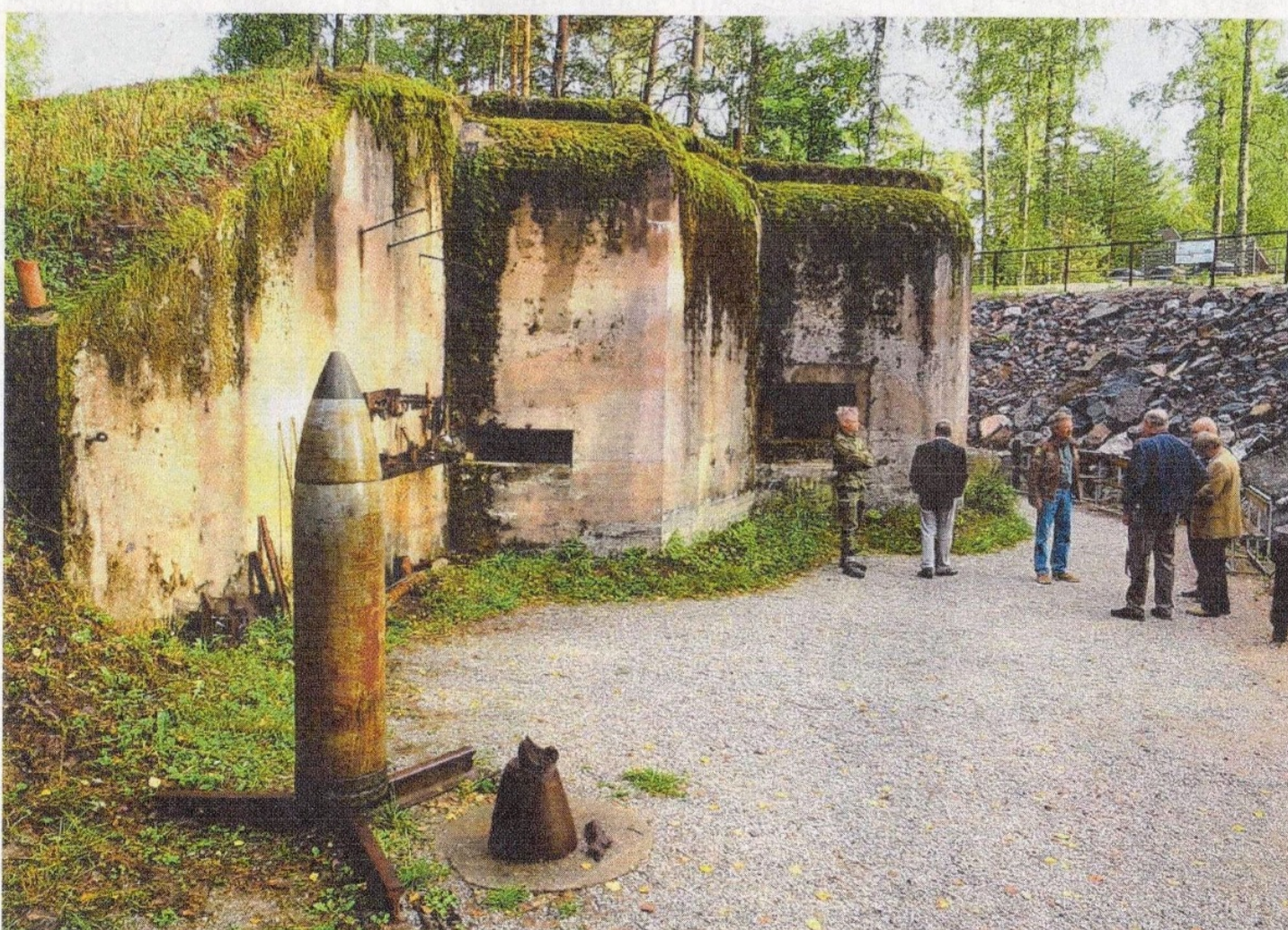
Massiivinen Irma-bunkkeri panssarintorjuntatykki- ja konekivääriaukkoineen. Edessä neuvostoarmeijan 300 mm rautatietykin ammus, jonka räjähdysen bunkkeri oli rakennettu kestämään.
