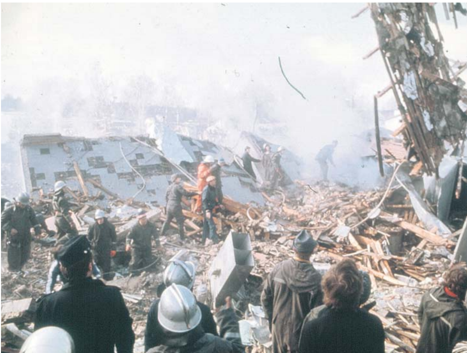
Raivaus- ja pelastustyöt ovat alkaneet. Kuva tekniikko Johan Salminen, tutkintaraportin aineistoa.
