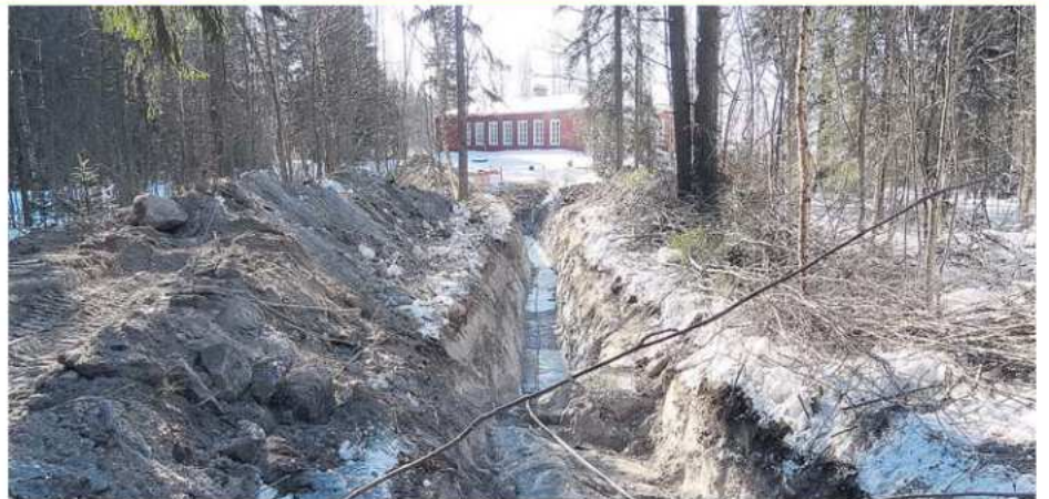
Vesijohtoverkosto lähestyy kohti taustalla näkyvää Kiltataloa. Peruskallio tuli vastaan paikoin ja vaatii louhintaa. rl
