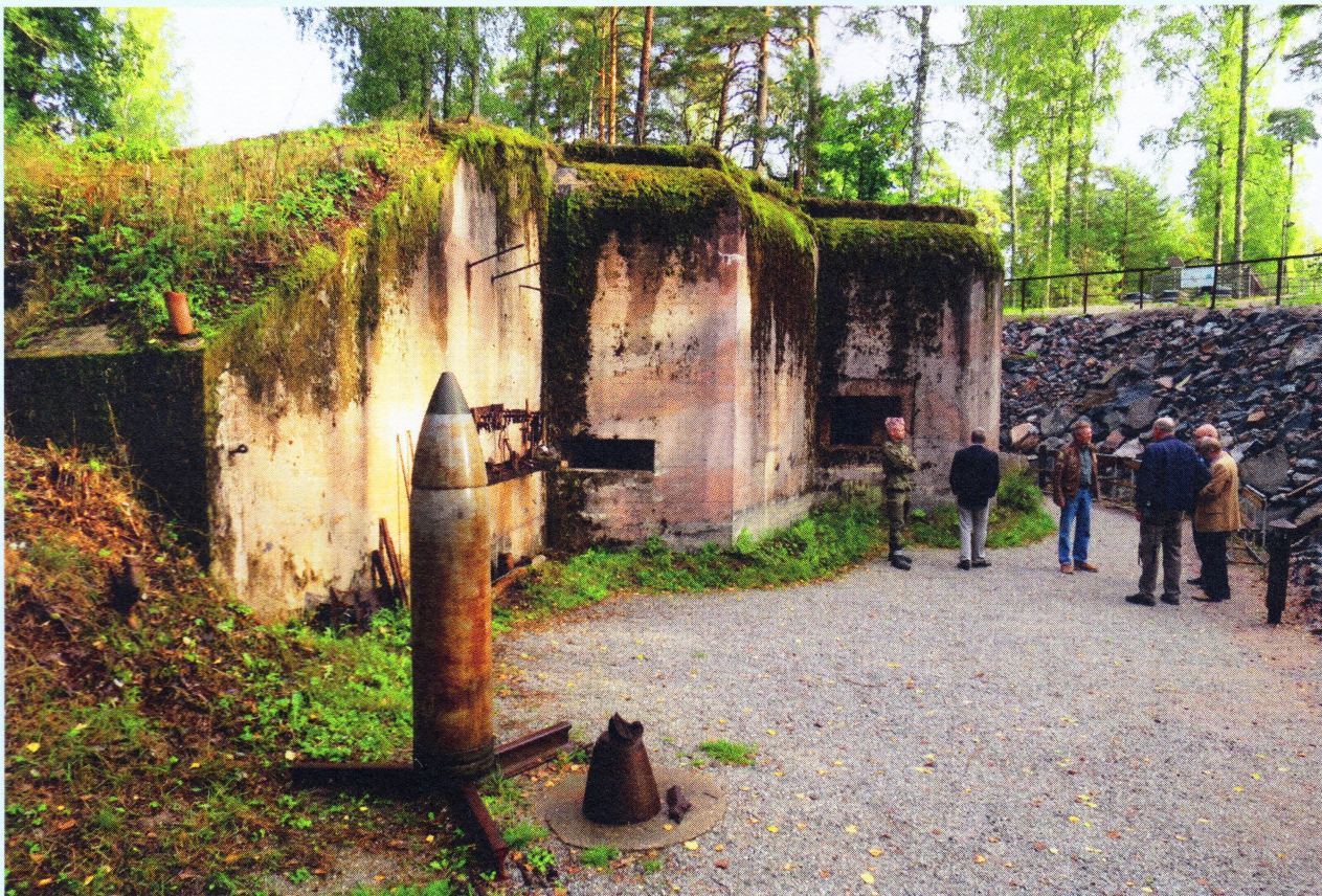
Massiivinen Irma-bunkkeri panssarintorjuntatykin ja konekiväärin ampuma-aukkoineen. Bunkkeri oli mitoitettu kestämään mm. etualalla näkyvän 300 mm rautatietykin ammuksen.
